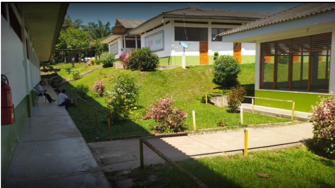
Oficinas del área administrativa y logística
