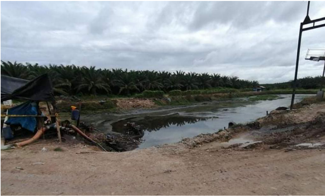
Laguna de oxidación
