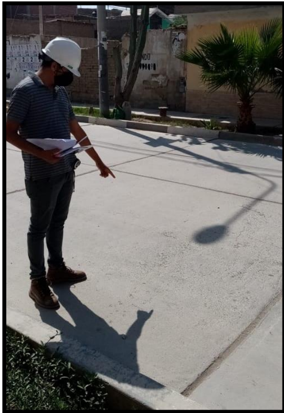
Tomas fotográficas de fallas en calle Baca Matos
