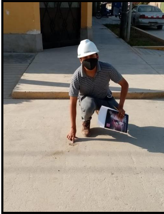
Tomas fotográficas de fallas en calle Los Geranios
