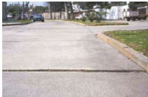
Figura 5: Falla de escala
