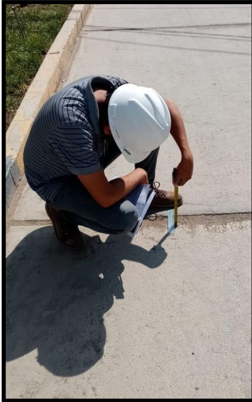
Tomas fotográficas de fallas en calle S/nombre
