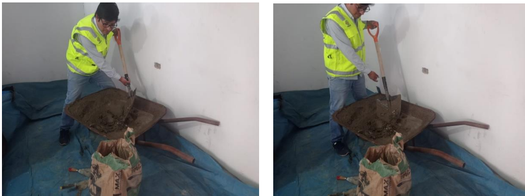
Figura 23. Mezcla de agregados con cemento
