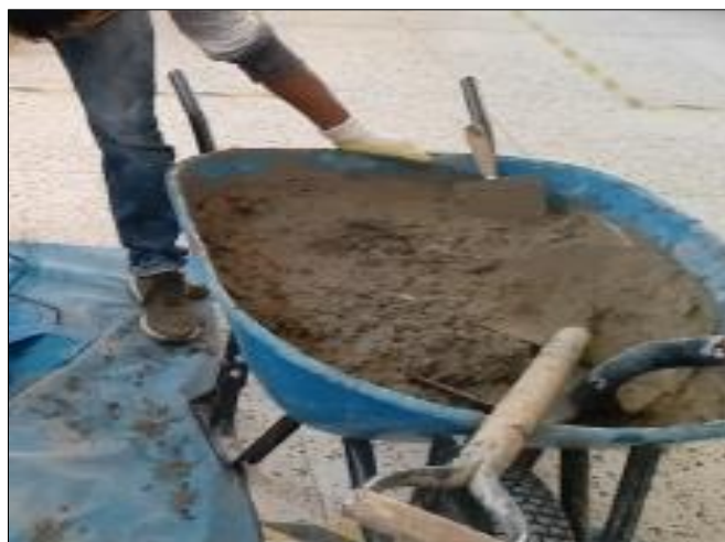
Figura 10. Concreto para la construcción
