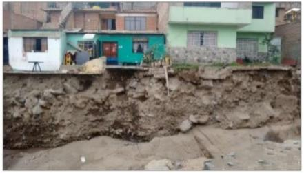
El área afectada, que se encuentra a la orilla baja aluvial del río Rímac, y modificado por acciones antrópica. (con relleno de desmonte). Todo ello provoca una fácil erosión del suelo y afectando la integridad de los pobladores.
