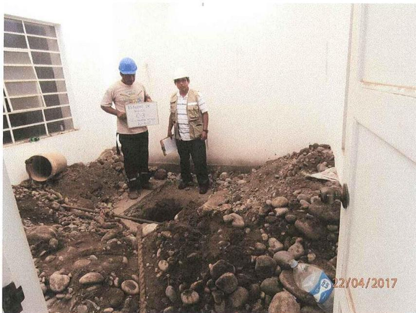
**FOTO N° 12:** Otra vista exterior de la calicata C-3, donde se muestra el material extraído de la excavación.
