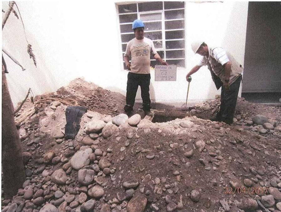
**FOTO N° 7:** Vista panorámica exterior de la excavación a cielo abierto denominado calicata C-2.
