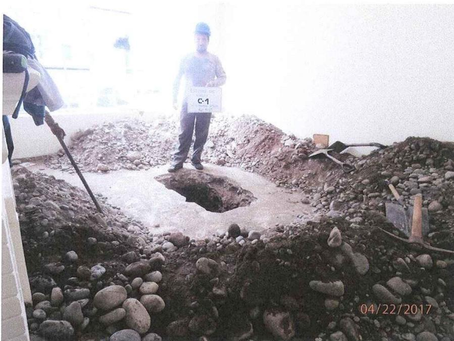
**FOTO N° 4:** Otra vista exterior de la calicata C-1, donde se muestra el material extraído de la excavación.
