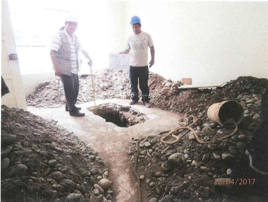
**FOTO N° 3:** Vista panorámica exterior de la excavación a cielo abierto denominada calicata C-1.
