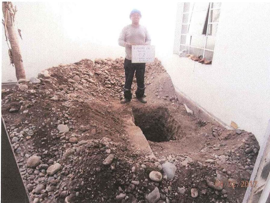
**FOTO N° 8:** Otra vista exterior de la calicata C-2, donde se muestra el material extraído de la excavación.
