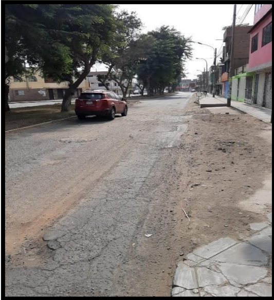
1) San Felipe, carril derecho de Este A Oeste progresiva 0+360
