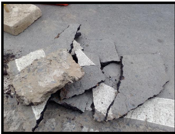
Imagen 4: Extracción de la carpeta asfáltica.
