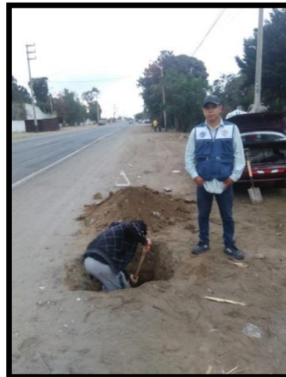
Imagen 17: Ejecución de las calicatas.
