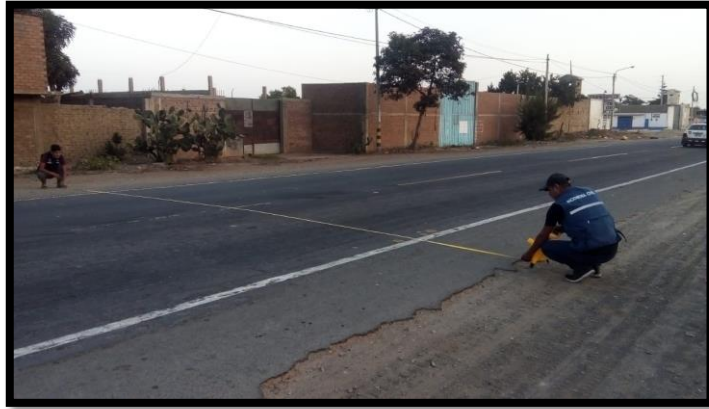
Imagen 13: Medición del ancho de calzada en el tramo 1
