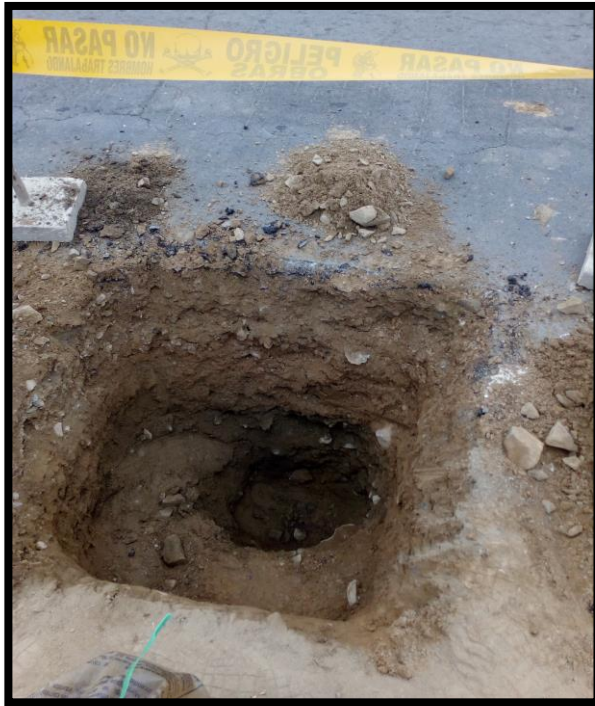
Imagen 6: Excavación de calicata
