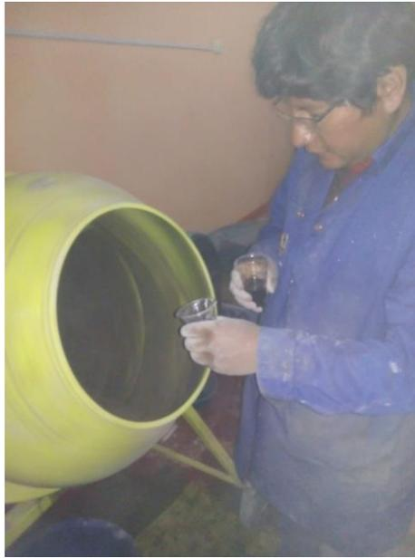
*Figura 17. Adición del superplastificante a la mezcladora*
