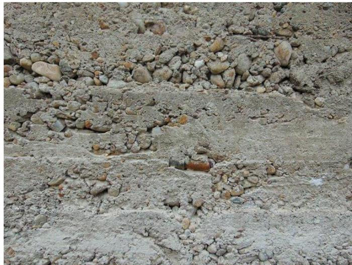
*Figura 3. Segregación del concreto.*
