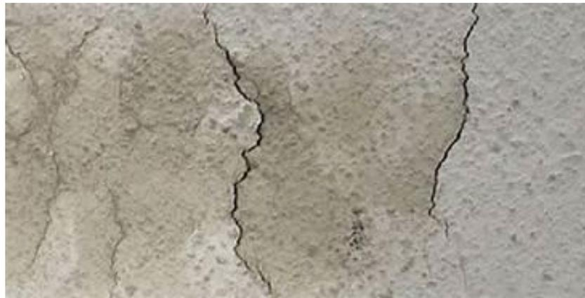
*Figura 5. Fisuras por contracción plástica del concreto.*
