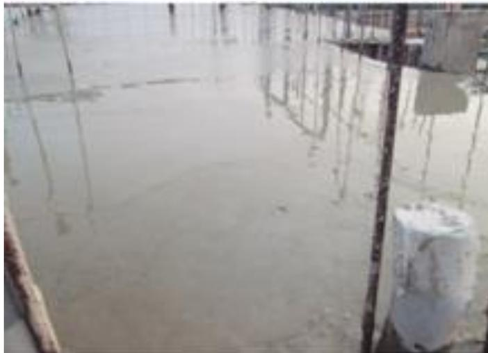
*Figura 4. Exudación alta en una losa de concreto.*
