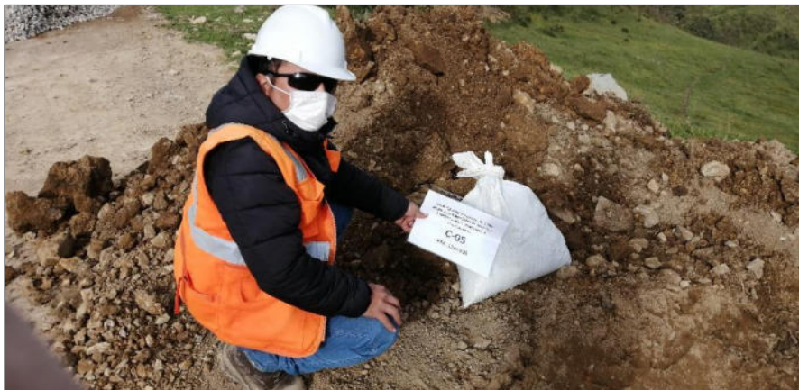
Figura 12: Excavación de calicatas Fuente: Elaboración Propia
