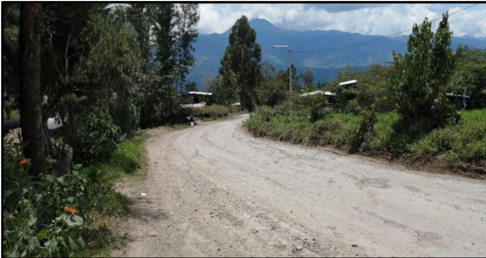
Figura 11: Estado de la vía Fuente: Elaboración Propia
