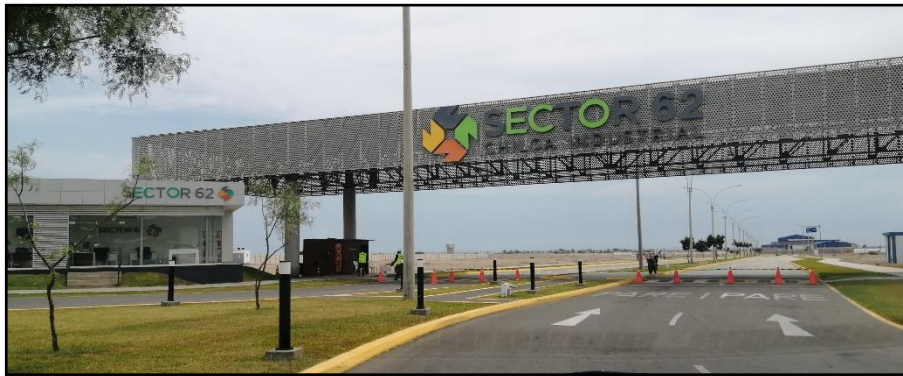
Figura 32: Foto del acceso principal, desde la V a Panamericana Sur, a la Zona Industrial Sector 62 en Chilca.
