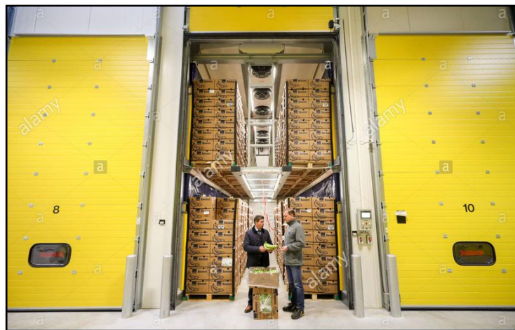
Figura 36: Cámaras de maduración y conservación programable para frutas y verduras. Fuente: Elaboración Propia
