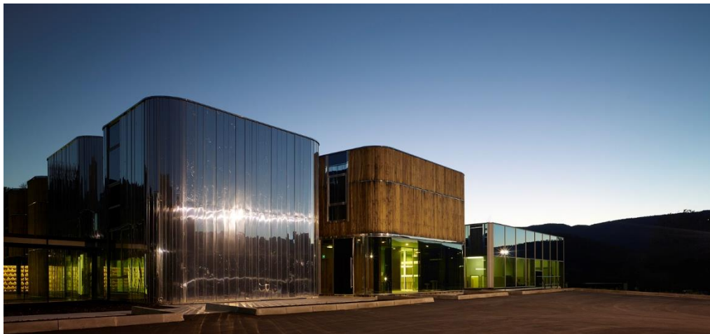
Figura 14: Vista donde se aprecian los materiales utilizados en la fábrica Industrial Salpi.
