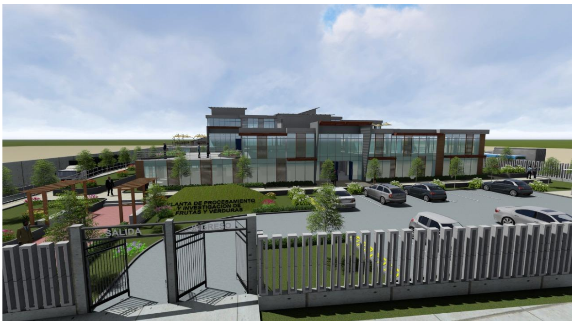
Vista General del proyecto. Fachada principal Fuente: Elaboración Propia
