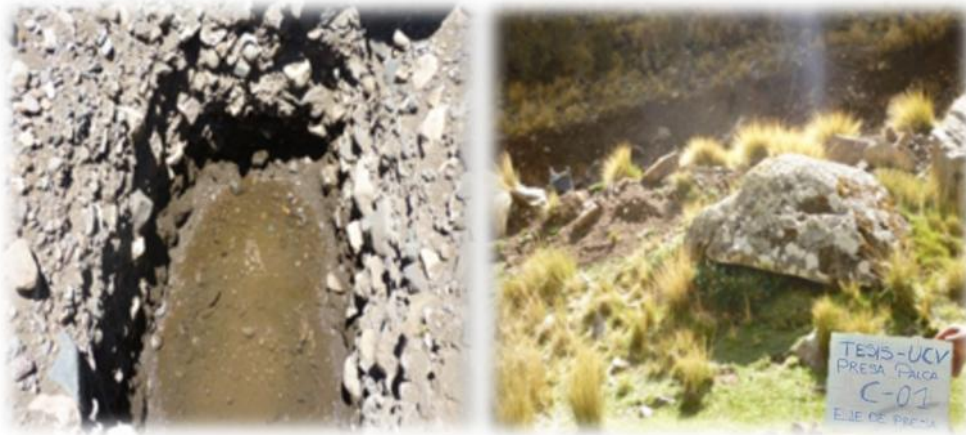
Figura 35. C-01 Eje de presa.
