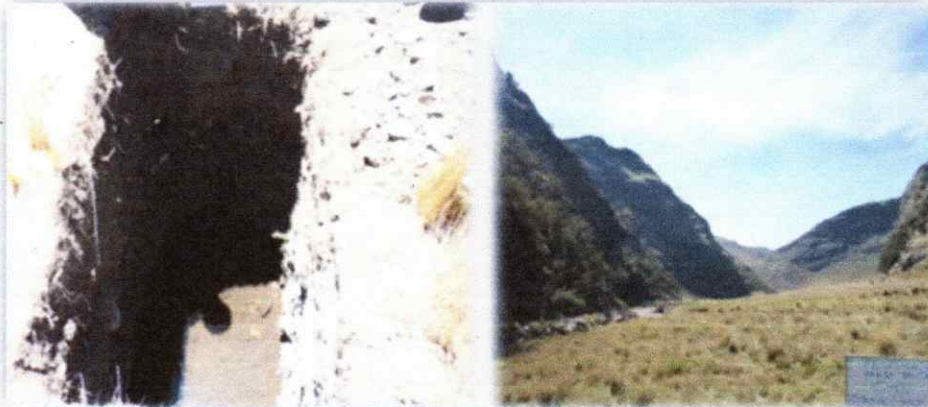
FOTO DE CALICATA 02- ZONA DE EMBALSE
