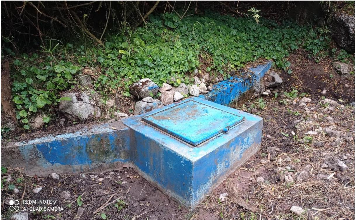
Fotografía 04: captación del manantial en precarias condiciones
