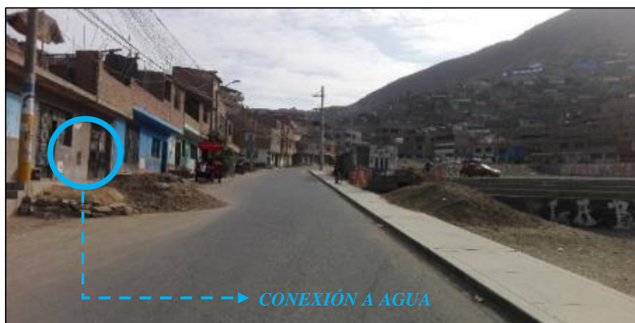
Figura 78: Servicio de Agua del sector. Elaboración Propia.
