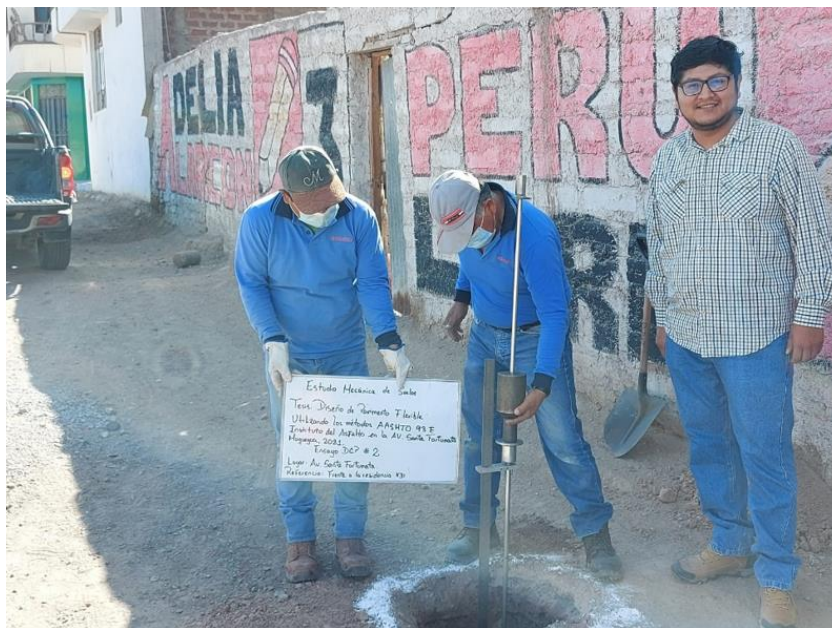
Fotografía 2. Punto 2 ensayo normal para el uso del D.C.P. en aplicaciones de pavimentos a poca profundidad ASTM 06951
