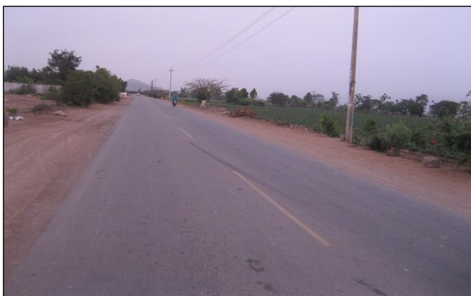
Figura 17 Vía asfaltada que comunica Quilmana con El Anexo Cinco Esquinas
