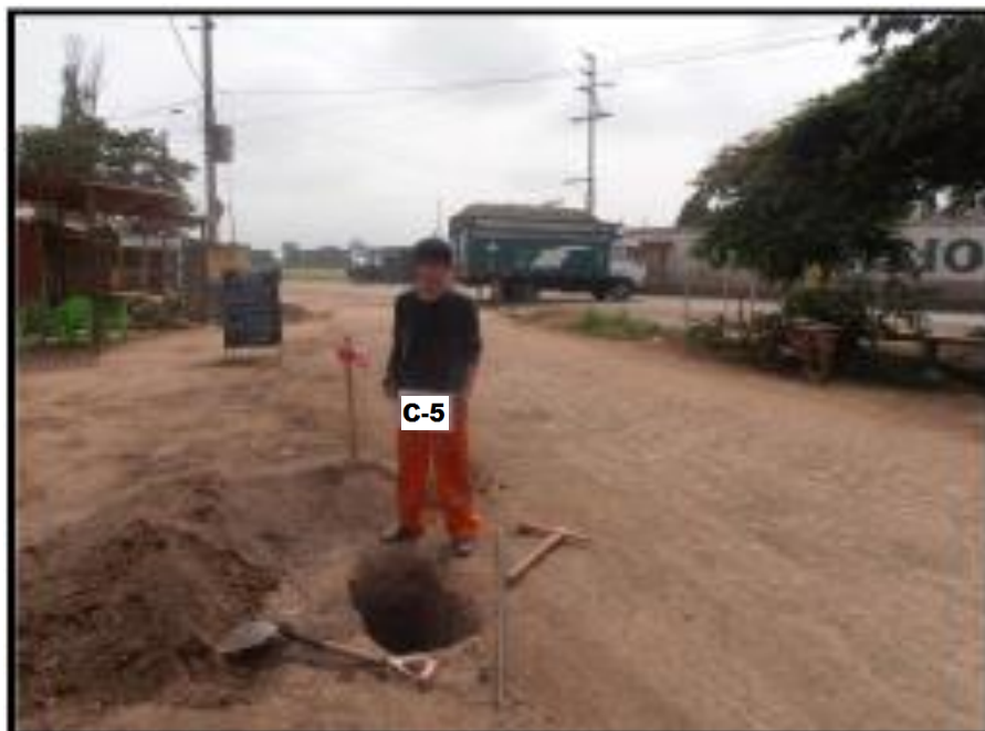
Figura 3 Vista General de la Calicata N° 5
