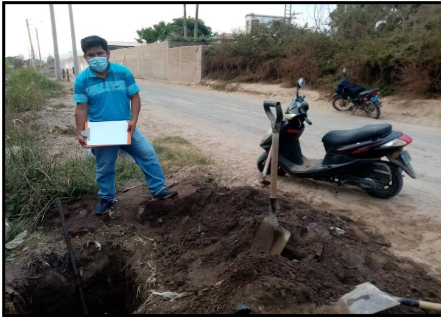
Figura 11 Vista General de la Calicata para TEST DE PERCOLACION
