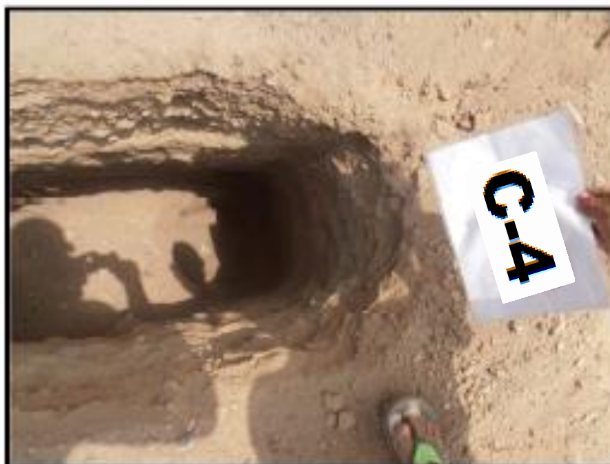
Figura 2 Vista de los Estratos en la Calicata N° 4
