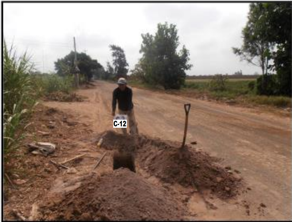
Figura 9 Vista General de la Calicata N° 12
