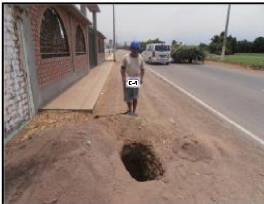
Figura 1 Vista General de la Calicata N° 4
