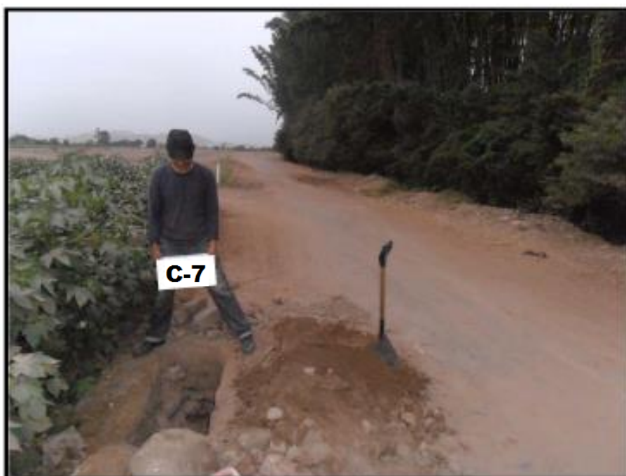
Figura 5 Vista General de la Calicata N° 7
