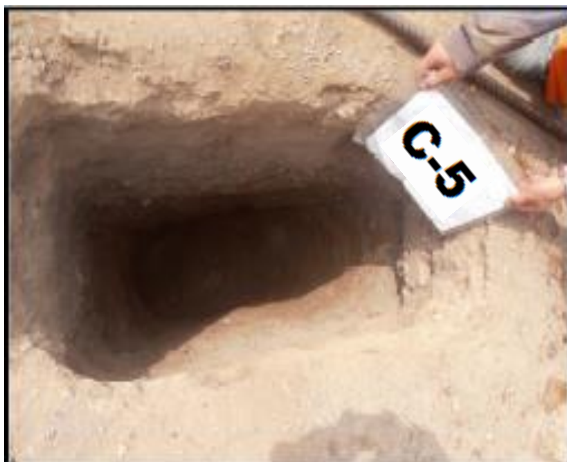
Figura 4 Vista de los Estratos en la Calicata N° 5
