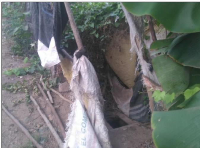
Figura 7 Evacuación de aguas residuales
