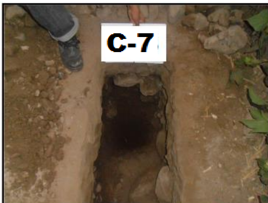
Figura 6 Vista de los Estratos en la Calicata N° 7
