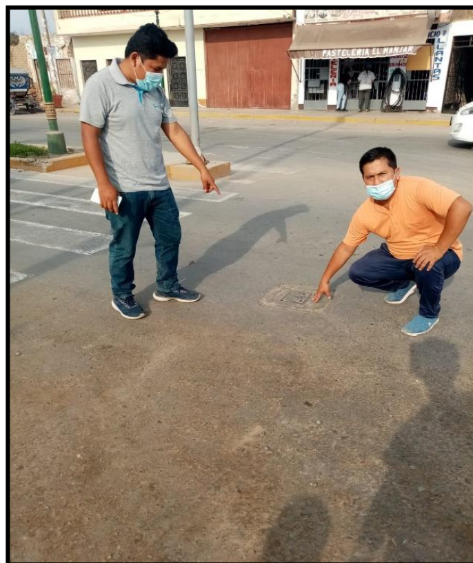
Figura 7 Vista de Valvula de la Red de Agua Potable existente (Proyeccion del punto de empalme)
