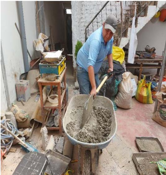
**FIGURA 19:** Mezcla de concreto de acuerdo al diseño de mezcla método ACI.
