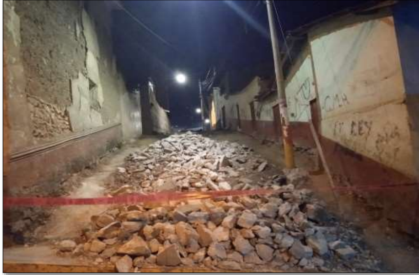
Foto N° 01 Muestra la recolección de residuos de demolición de pavimento rígido en el distrito de Andahuaylas.
