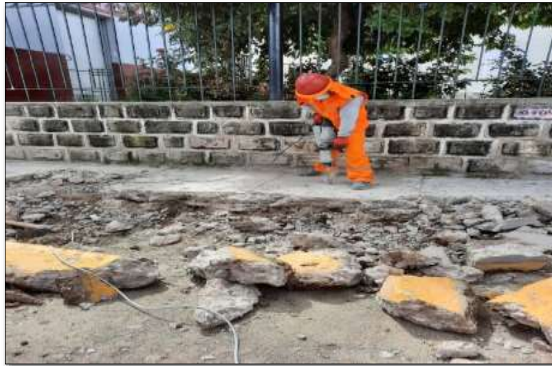
Foto N° 02 Muestra la recolección de demolición de veredas en el distrito de San Jerónimo.
