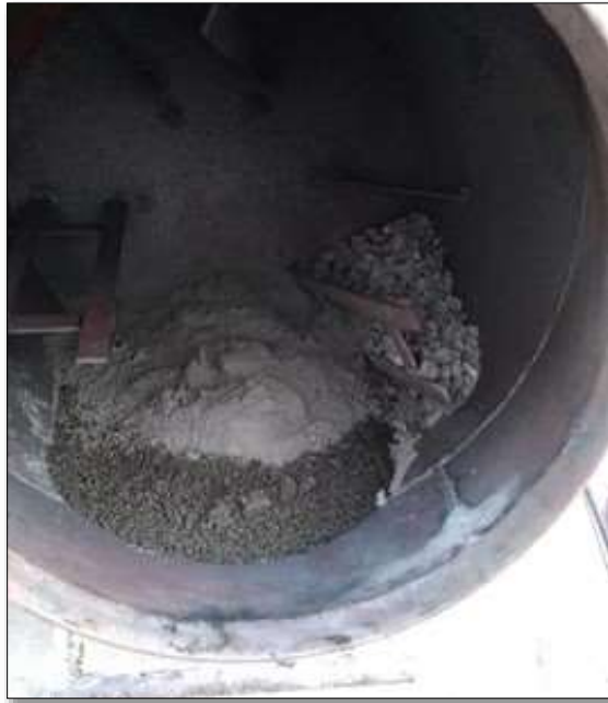
Foto N° 13 Muestra el preparado de la mezcla de concreto.
