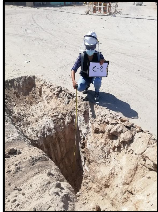
CALICATA N°02 (C-2)
