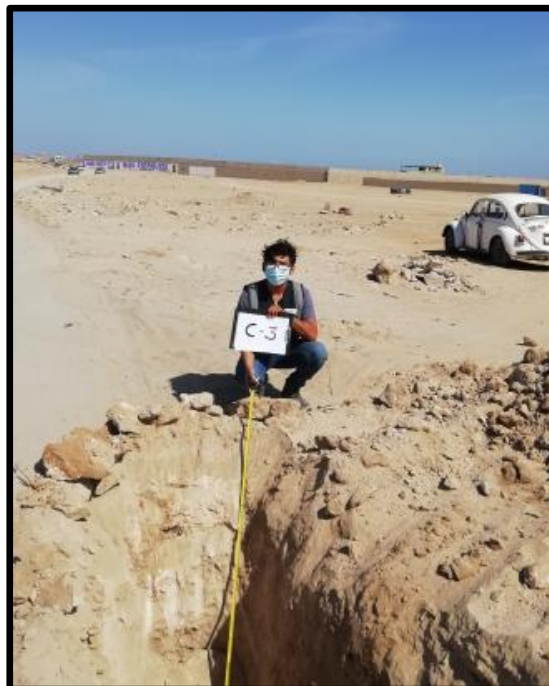
CALICATA N°03 (C-3)
