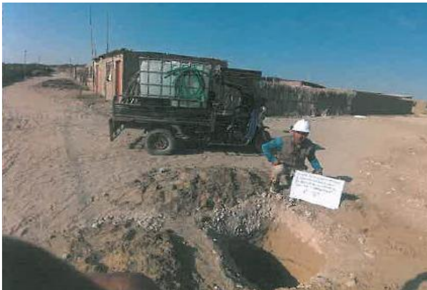
Foto N°4. Proceso de excavación de calicata #4
