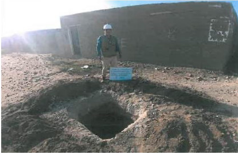
Foto N°3. Proceso de excavación de calicata #3
