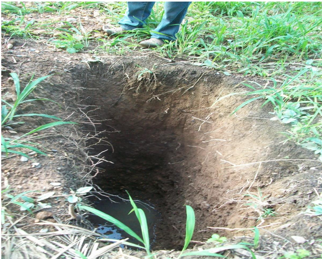
Figura 16: Foto 6. Calicata C-1 para tanque séptico
