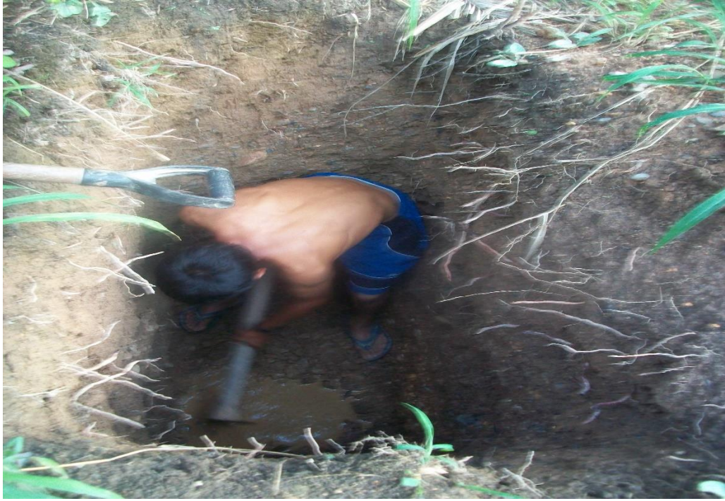
Figura 15: Foto 5. Excavación de calicata C-1
