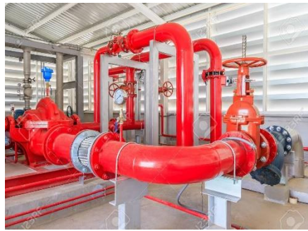
Figura 3. Estación de bombeo para riego.
