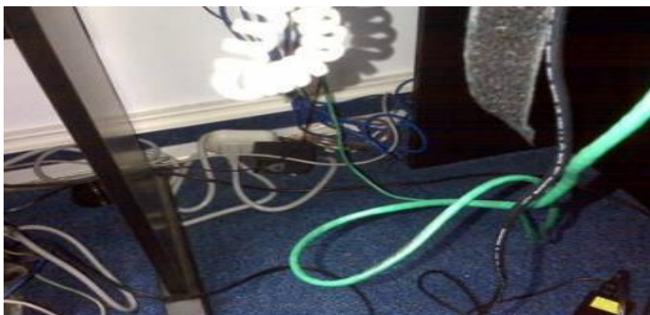
Figura 13. Cables sueltos
