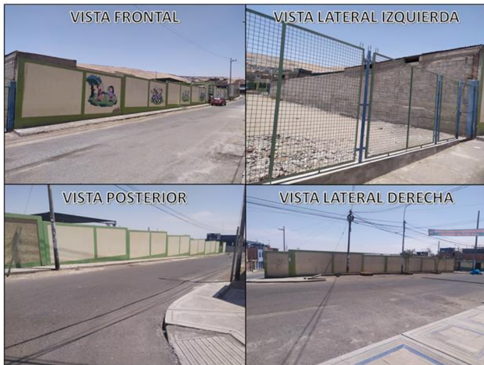
Fotografía 7. Cerco perimétrico de la I.E.I. Santa María.
