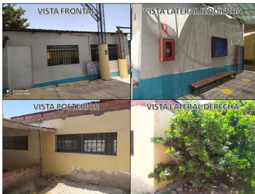
Fotografía 2. Bloque B de la I.E.I. Santa María.
