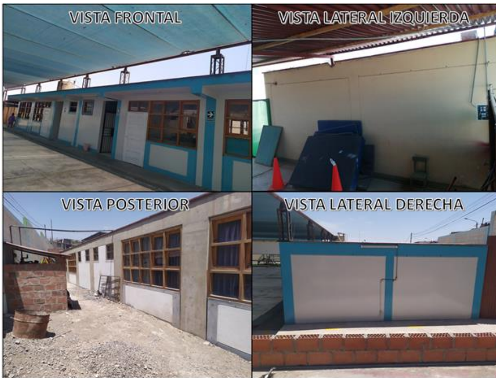
Fotografía 4. Bloque D de la I.E.I. Santa María.
