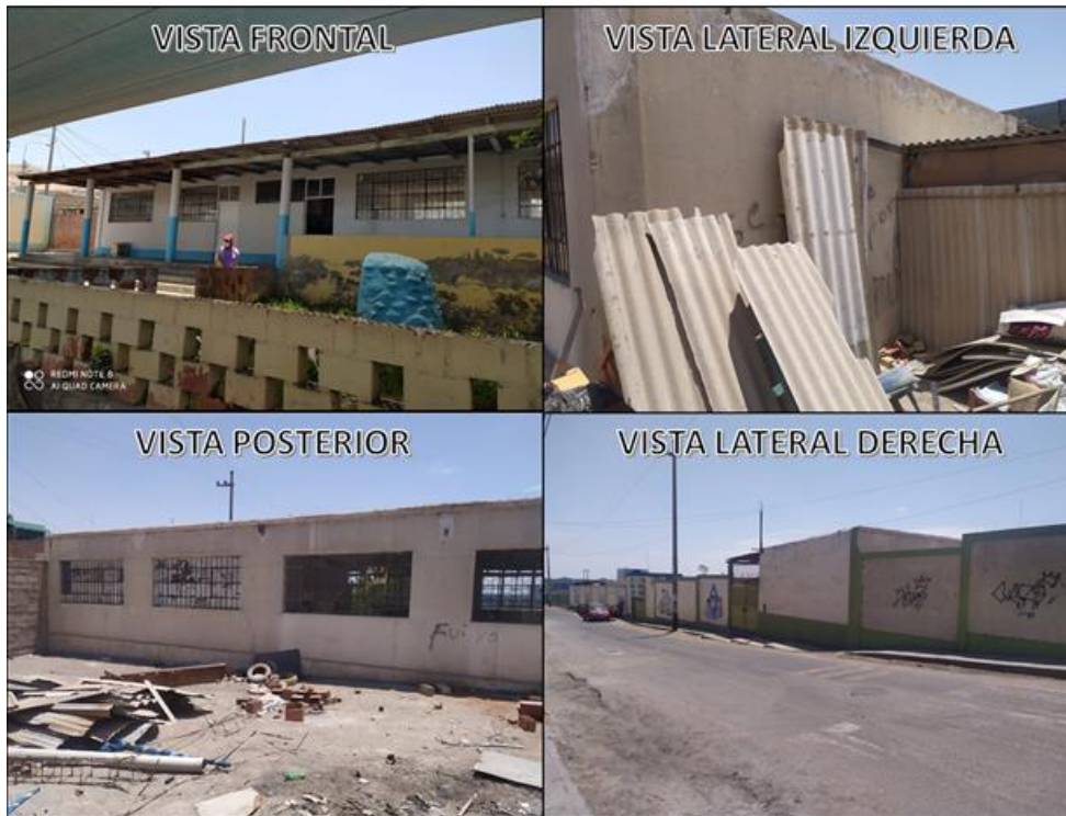
Fotografía 1. Bloque A de la I.E.I. Santa María.
