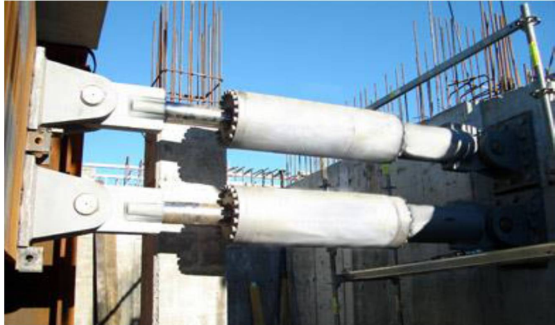
Figura 11: Disipadores de fluido viscoso. (Maurer Sohne)
