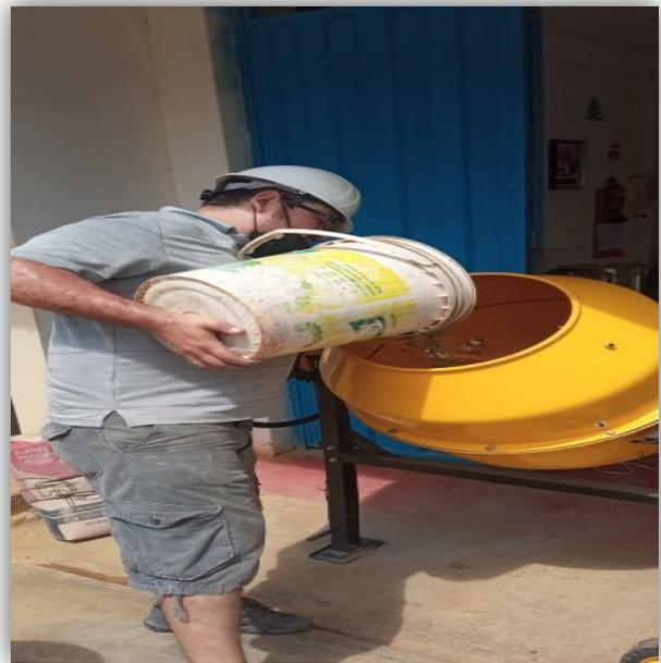
Procedimiento de mezclado de los agregados en la mezcladora
