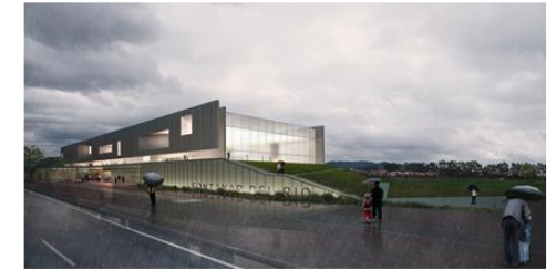
FACHADA 1 (SUR): a los barrios y infraestructuras
