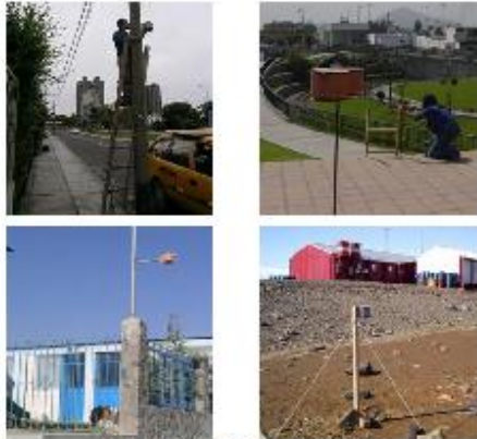
Instalación de los contenedores
