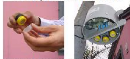
Retirar la tapa e instalar dentro del contenedor
