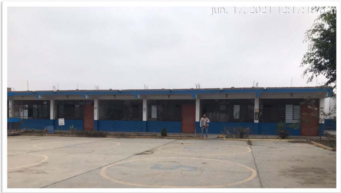
Foto 11. Aulas de nivel secundaria
