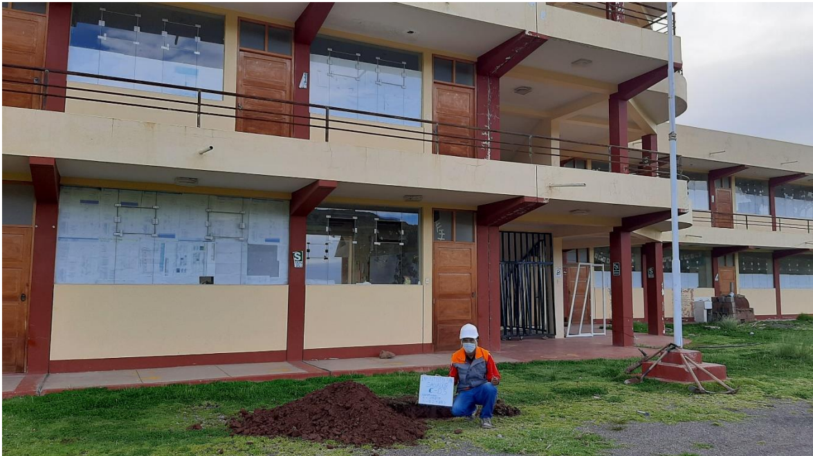
Fotografía 6.4 Vista panorámico de excavación de calicata C-03 y verificando la profundidad mínima de 1.50m con sus respectivas coordenadas UTM, del Instituto Superior Tecnológico Público San Salvador
