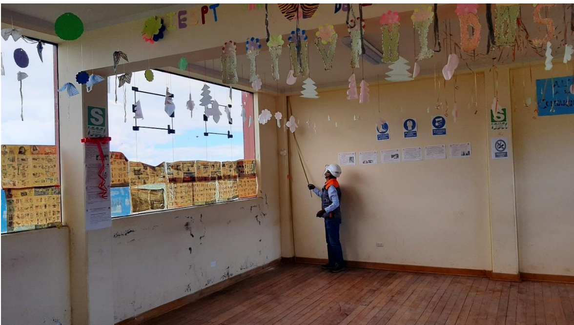
Fotografía 6.2 Verificación de medidas interiores de vigas del Instituto Superior Tecnológico Publico San Salvador
