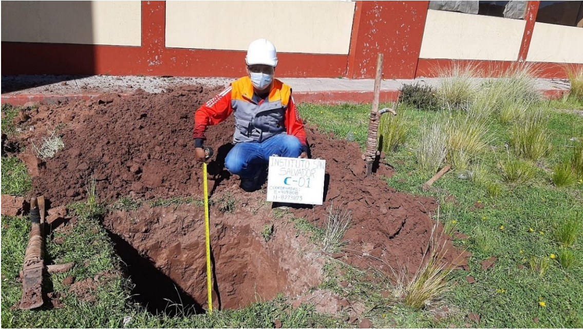
Fotografía 6.3 Vista panorámico de excavación de calicata C-01 y verificando la profundidad mínima de 1.50m con sus respectivas coordenadas UTM, del Instituto Superior Tecnológico Público San Salvador
