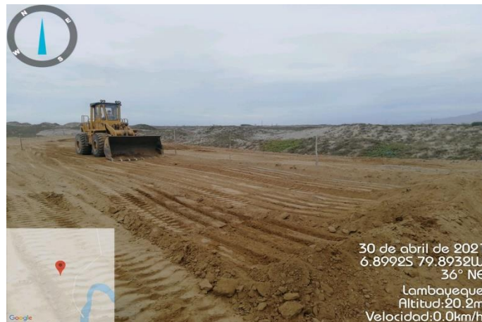
Figura 02. Nivelación de terreno
