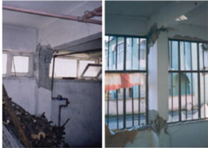
Formación de columnas cortas causadas por ventanas de cinta (METU / EERC, 2011).Fuente: M.T. Cogurcu, 2015.
