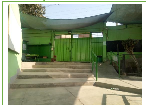
Vista ingreso principal desde el interior
