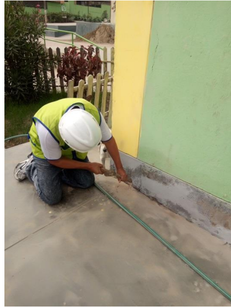
Inspección el estado actual del Recubrimiento.
