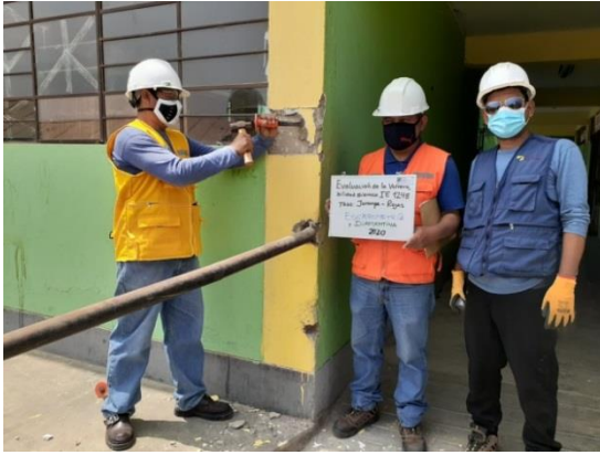
Retirando el tarrajeo de la columna Para los ensayos de Esclerometría.
