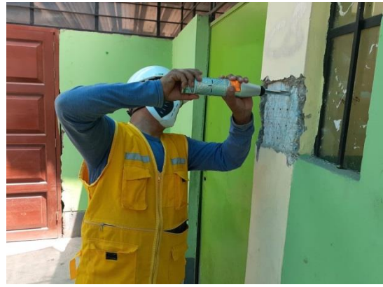
Realizando el ensayo de Esclerometría en columna.
