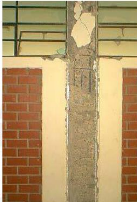
Fig. 22 El espaciamiento de la junta es menor al desplazamiento lateral
