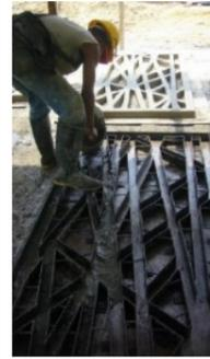
Una membrana arquitectónica compuesta por paneles de concretos prefabricados en el sitio.
