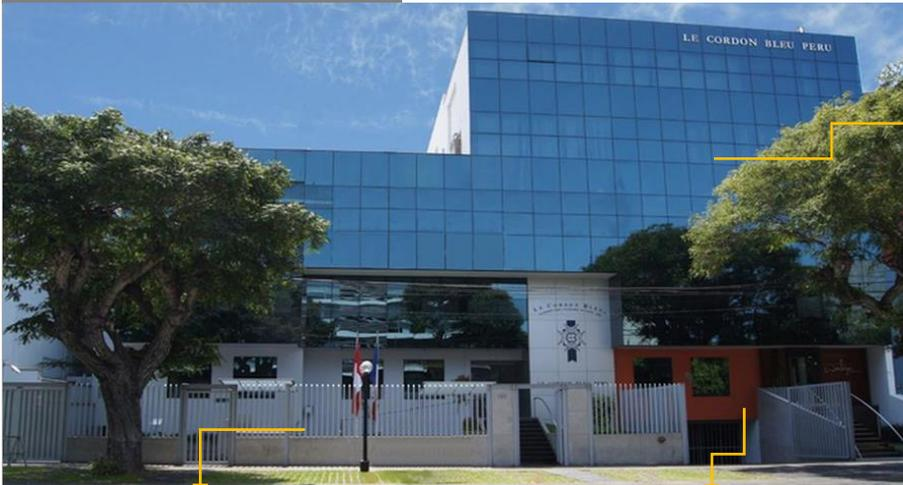
Muro cortina: Toda la fachada se ve revestida con vidrio y perfiles de aluminio y le otorga un carácter lujoso al edificio, dicho material contrasta con los demás, es por ello que permite resaltar el bloque que componen las aulas.
