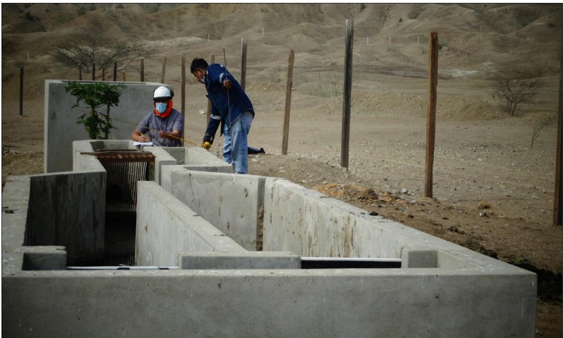
Figura 8 Toma de las medidas del área de la cámara de rejás
