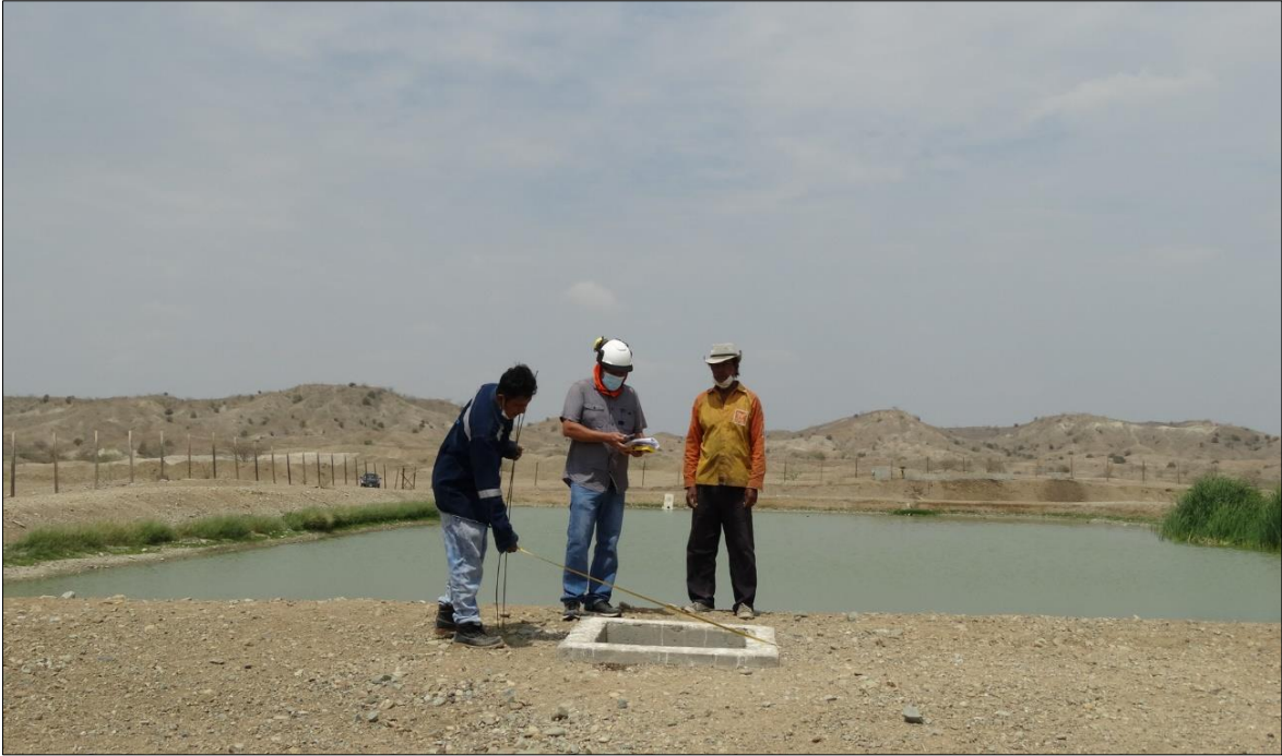
Figura 21 Toma de las medidas del área de la cámara de inspección
