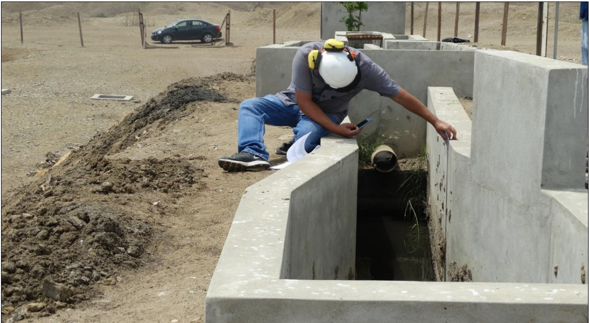
Figura 16 Toma de las medidas del área del medidor Parshall
