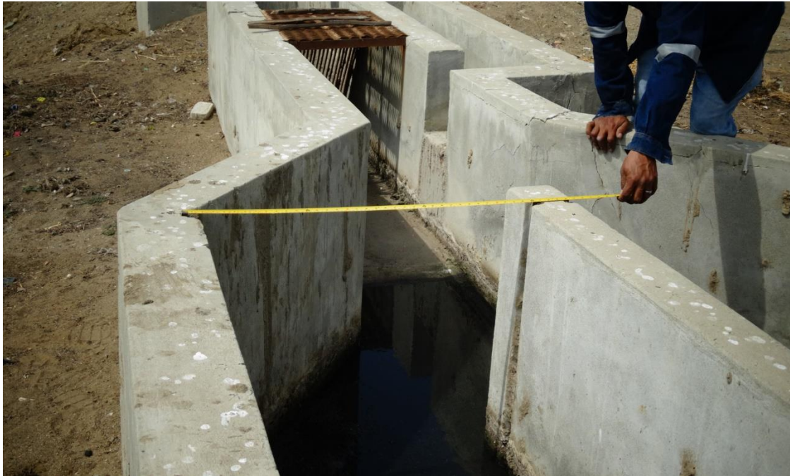
Figura 13 Toma de las medidas del área del desarenador
