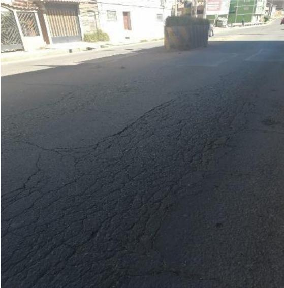
Fallas longitudinales existentes del carril derecho en el km 2+100.
