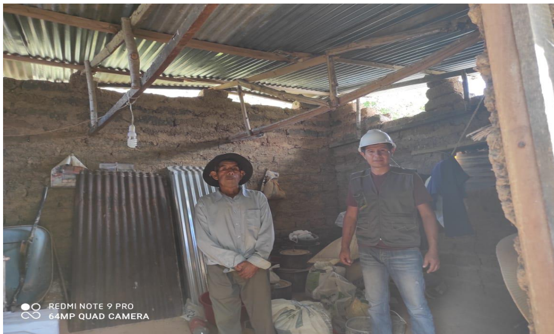
Anexo: 1 Vivienda del beneficiario del módulo.
