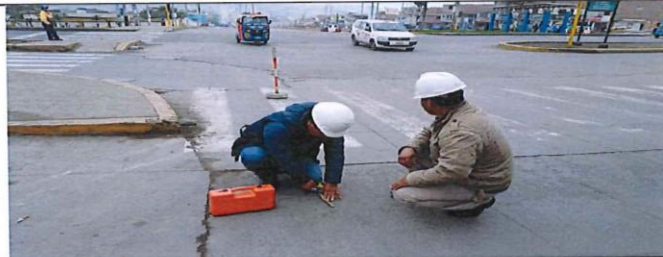
FOTO N° 1 : Realizando aplicación del ensayo con esclerómetro en la cara superior del pavimento rígido, con la finalidad de obtener su resistencia del concreto.
