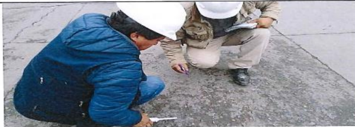
FOTO N° 4 : Realizando aplicación del ensayo con esclerómetro en la cara superior del pavimento rígido, con la finalidad de obtener su resistencia del concreto.
