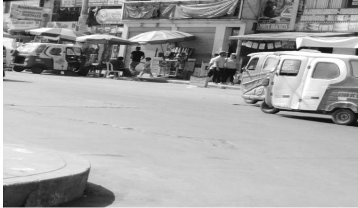
Figura 1. Calle en Villa el Salvador con fisuras Fuente: Propia
