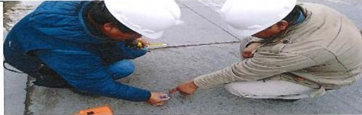
FOTO N° 2: Realizando aplicación del ensayo con esclerómetro en la cara superior del pavimento rígido, con la finalidad de obtener su resistencia del concreto.
