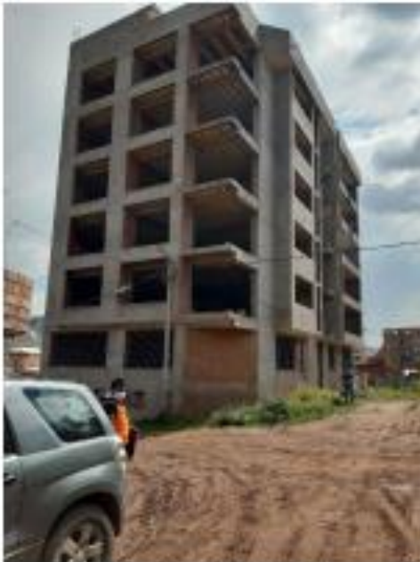
FIG. N° 7: Edificio N° 01, de 6 niveles
