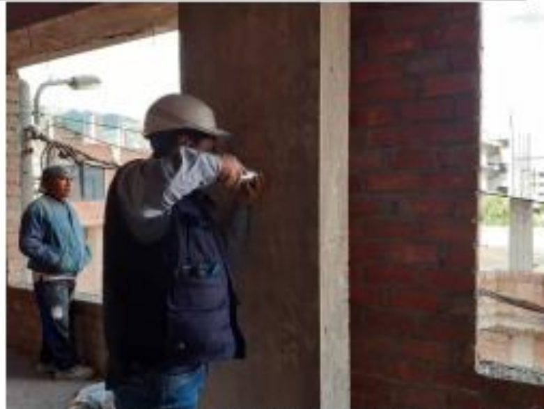
Fig. N° 8. Esclerometría en columna del 2do nivel, Edificio N° 03
