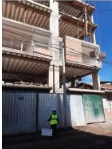
FIG. N° 2. Edificio N° 01, de 3 niveles
