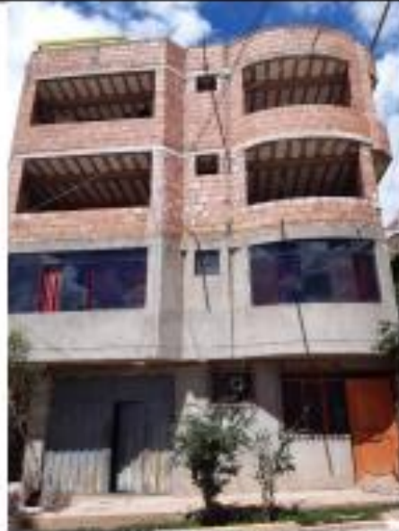
FIG. N° 4: Edificio N° 02, de 4 niveles.
