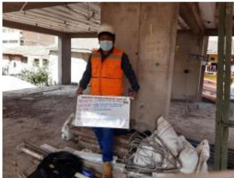
FIG. N° 3. Evaluación de asentamiento en placa del 2do nivel
