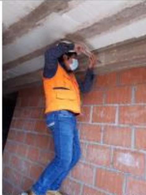
FIG. N° 6: Esclerometría en viga, 2do nivel de edificio N° 02
