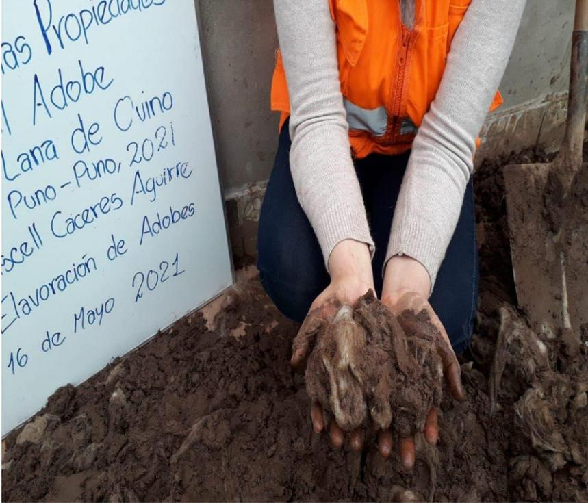
Figura N°09: Preparación de la mezcla del adobe
