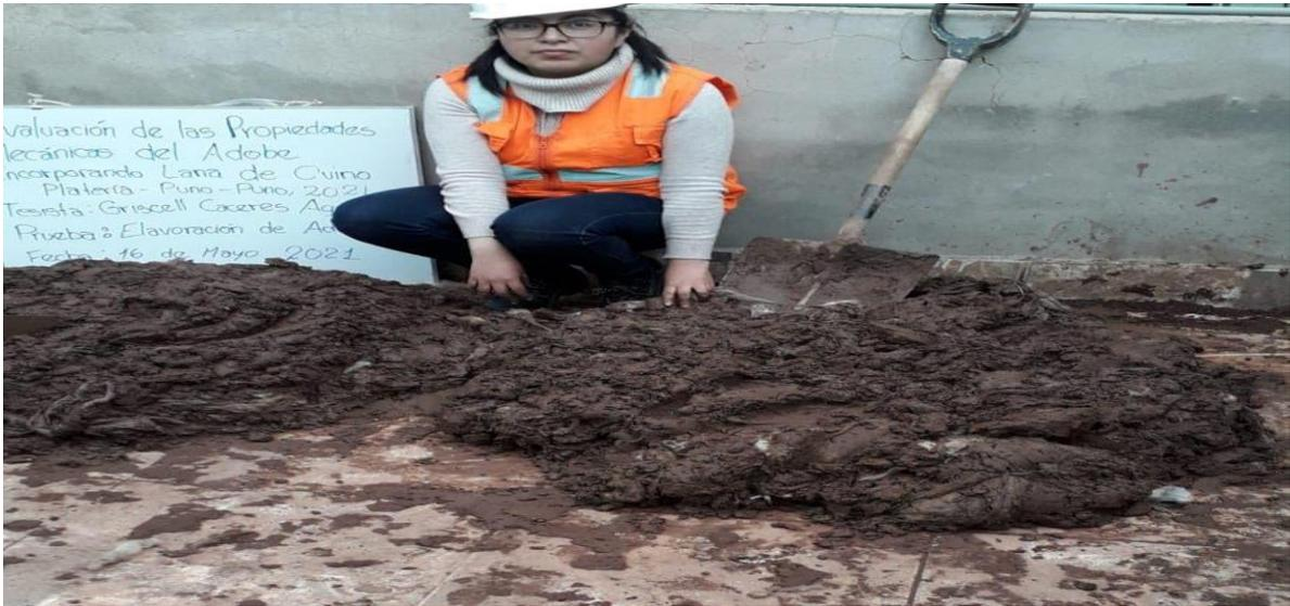
**Figura 13.** Mezclando el suelo con lana de ovino
