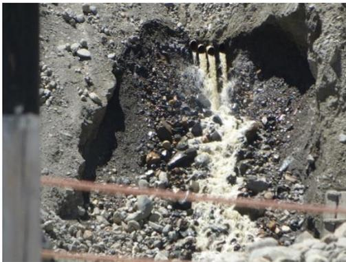
Figura 25: Conductos de efluentes mineros.
