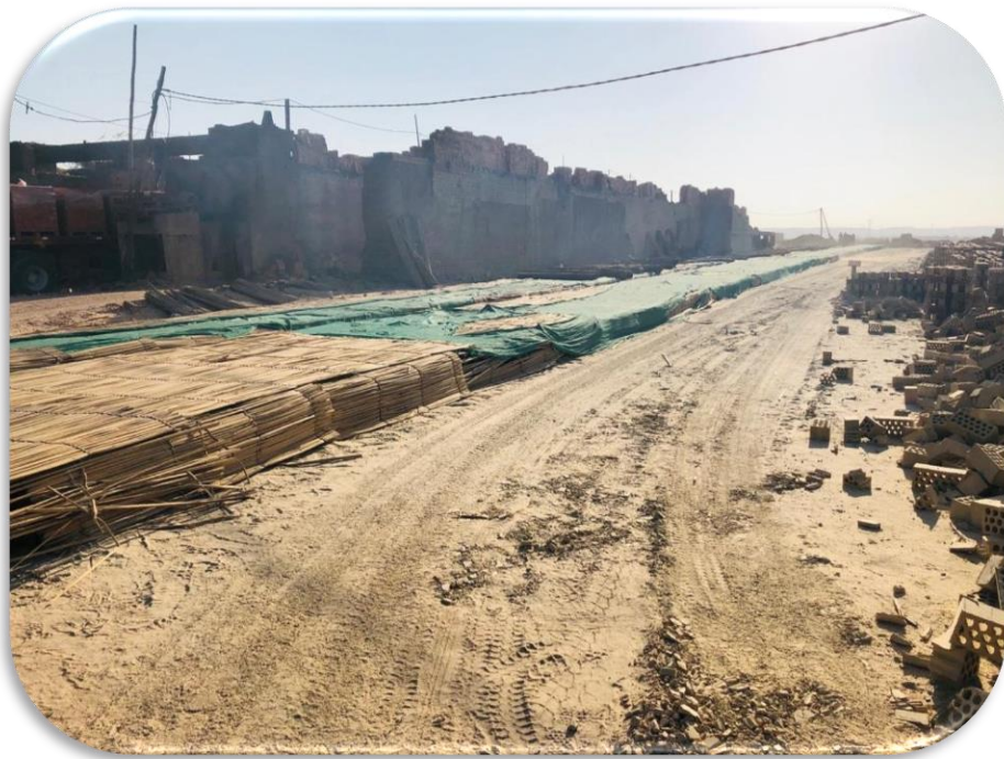
Figura 12: Secado de ladrillos protegidos con esteras y mantas de malla rachel
