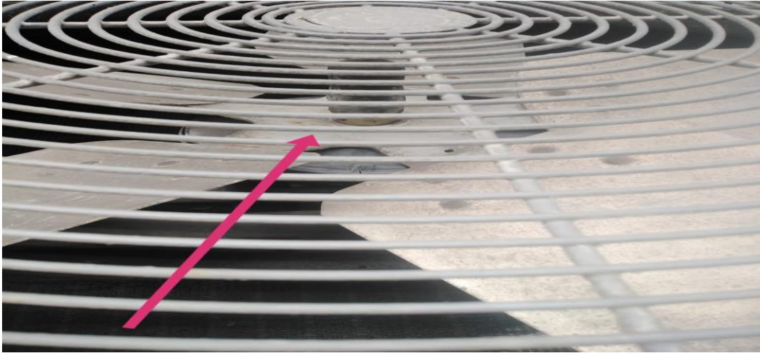
Figura 9: Hélice de motor desprendida por mal ajuste Fuente: Propia
