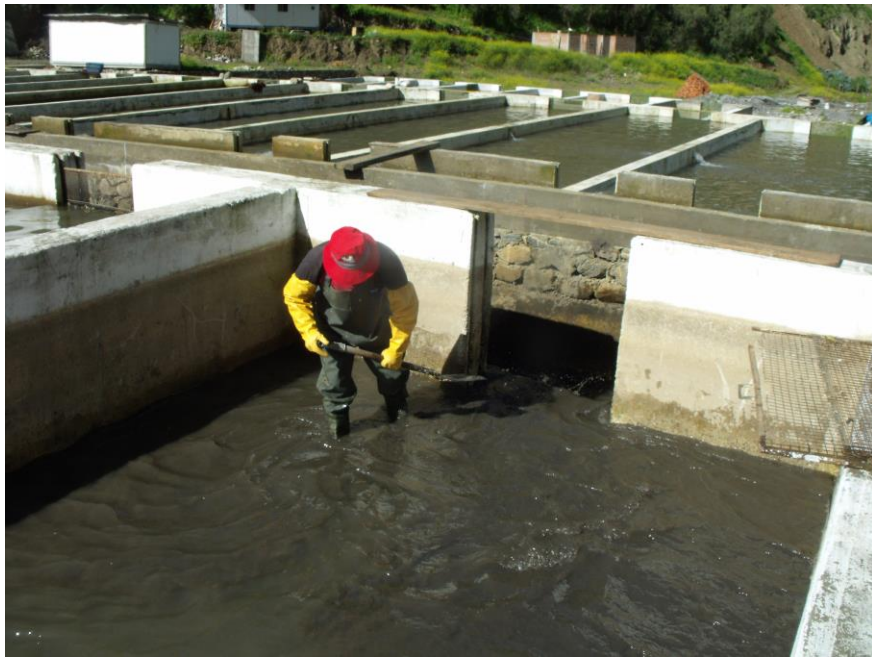
Figura 25. Extracción de lodos
