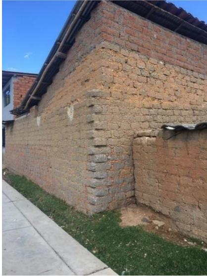
Nota. La siguiente imagen se detalla el material autóctono de la sierra liberteña, donde se destaca la pureza del adobe. Se visualiza notablemente que esta vivienda fue autoconstruida, por la variedad de tonalidades del adobe, sus medidas y el mortero empleado en la unión de los mismos.
