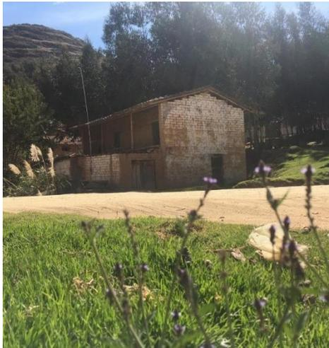
Nota. En la siguiente imagen se aprecia un revestimiento exterior de yeso para conseguir una mayor duración de la vivienda. En los muros interiores el revestimiento se muestra de forma natural, el color natural del barro, compatibilizando colores con la estructura de madera y teja andina.
