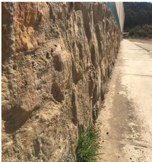
La siguiente imagen detalla una base de piedra irregular de entre 2 y 3 cm de espesor, acabado natural esto es una base de un metro de altura sirve para proteger los muros de la humedad.
