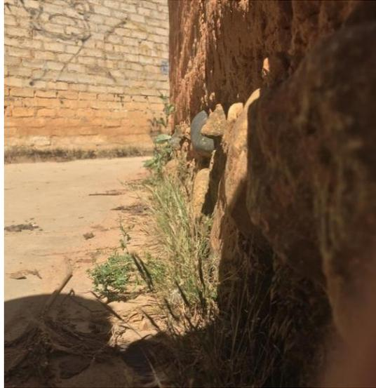
Nota. La siguiente imagen detalla la base de la vivienda, siendo éstas de piedra irregular, a fin de proteger los muros de adobe de la humedad o la circulación de agua provocada por las lluvias.
