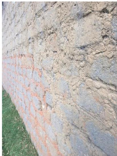
Nota. La siguiente imagen detalla el mortero para la unión de los adobes dicho mortero está conformado por paja y piedras pequeñas; los pobladores del lugar que no cuentan con los recursos suficientes elaboran este material básicamente con la tierra y agregados del mismo terreno.
