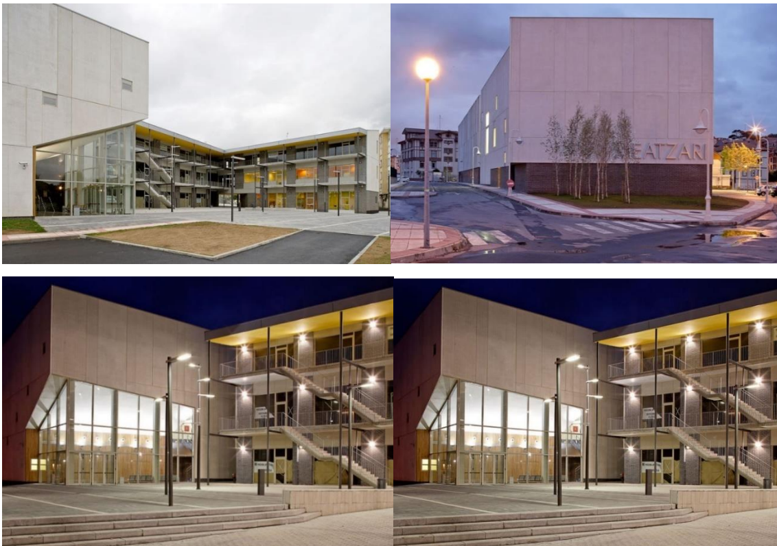
Figura 88: Centro cívico comercial: “Meatzari” / Virai Arquitectos”
