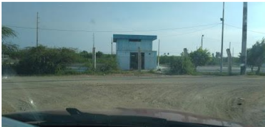
Planta de tratamiento de agua potable EPSEL
