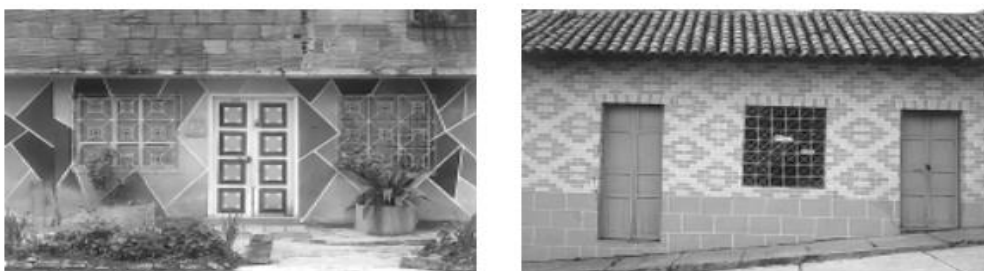
Figura 3: Acabados a la Fachada.
