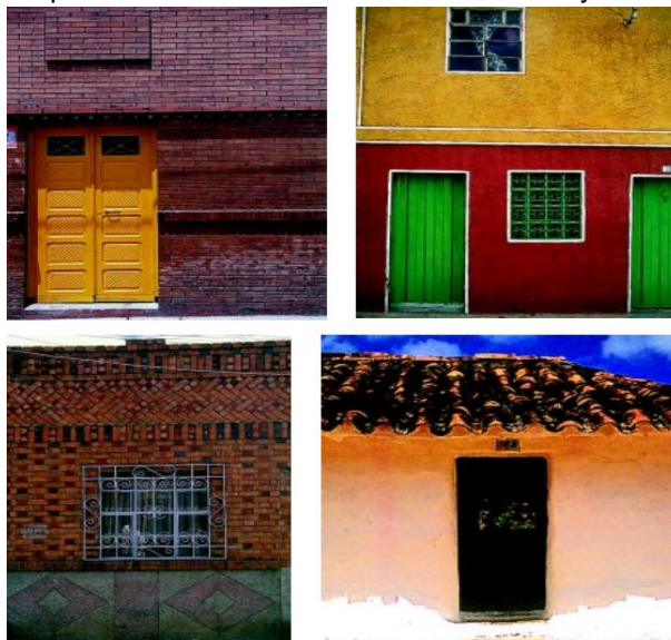
Figura 2: Tratamiento a la Fachada.
