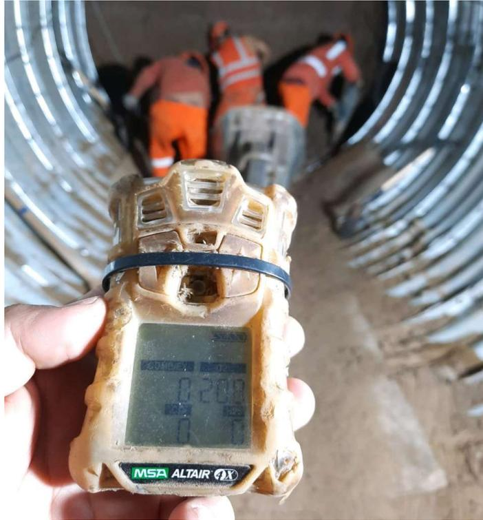
Toma de datos con el detector de gas Altair 4X, en el Túnel Liner 690 ml. Profundidad de 8 m.
