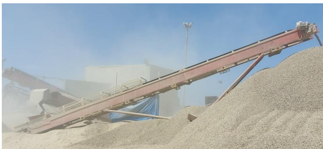
Figura : 2 , Faja transportadora Finlay Fuente: Elaboración propia
