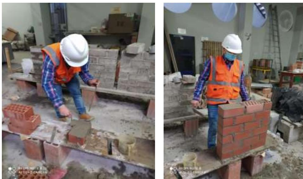
*Figura 19.* Observamos la aplicación del mortero el mortero embolsado Rapimix, así como la cantidad de material, para la elaboración de muretes de albañilería con ladrillo Tipo A.
